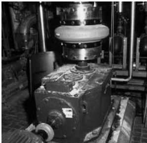
Rexnord Omega联轴器无论是水平安装或垂直安装都不需额外的组件。安装方便，便于维修，目视检查，使其成为许多应用中的必须产品。例如上图中酿酒厂的捣碎机。
